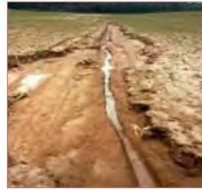
b) Érosion en rigoles
